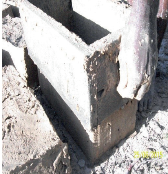
Figura 3. Retirada do adobe da forma
